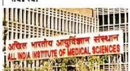
भारत हेल्थ इंफ्रस्ट्रक्चर मिशन के तहत पीएम केयर फंड से एम्स में क्रिटिकल केयर व संक्रामक रोग केंद्र बनाने की पहल की गई। एम्स ने इसके निर्माण के लिए पिछले वर्ष 30 जनवरी को निर्माण की योजना बनाई थी। क्योंकि कोरोना के संक्रमण के दौरान अस्पतालों में आइस्यू, आइसोलेशन वाई आदि सुविधाओं की कमी महसूस की गई। इस वजह से अस्पतालों में दूसरी बीमारियों का इलाज बंद करके कोरोना के इलाज की व्यवस्था करनी पड़ी थी। एम्स में दूसरी मंजूर हो रही है। एम्स में दूसरी मंजूर हो रही है। एम्स में दूसरी मंजूर हो रही है।
